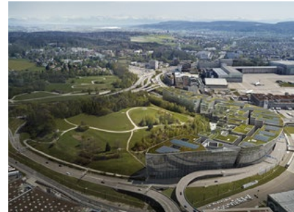
Neubau «The Circle» Zürich Flughafen
